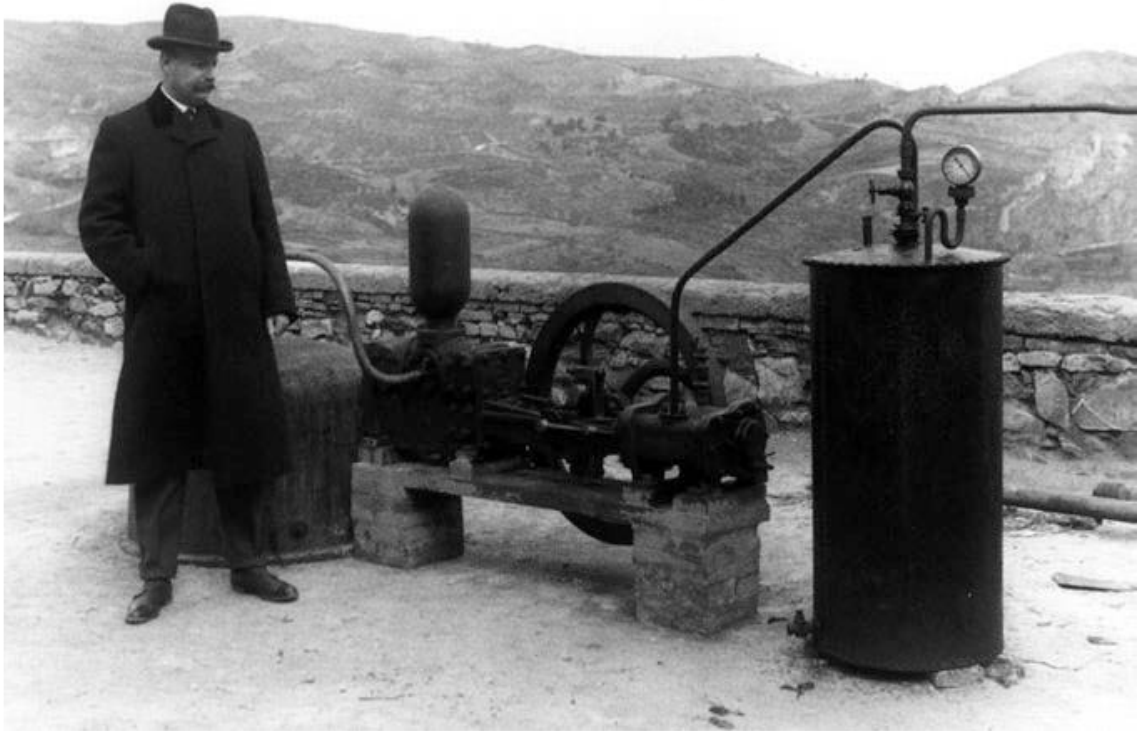
Slika 4-1. Parni stroj u Larderellu koji je proizvodio struju za 5 žarulja (Stober i Bucher, 2013)
