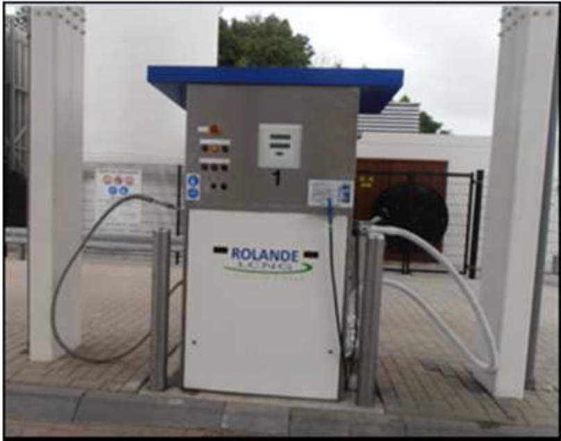
Slika 5-4 UPP dispencer za cestovna vozila (Gallego, 2014.)
