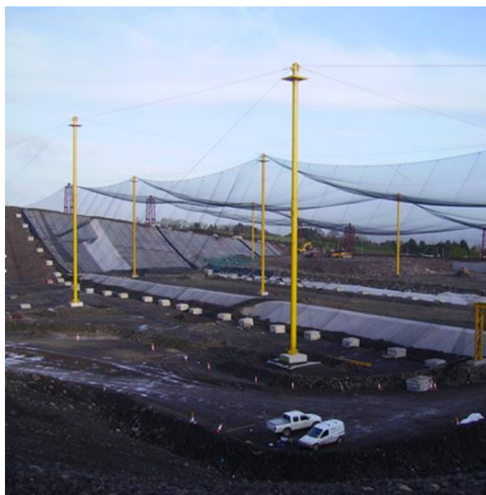
Slika 3-4 Tehnika zaštite protiv ptica mrežama (Waste solutions, 2018)
