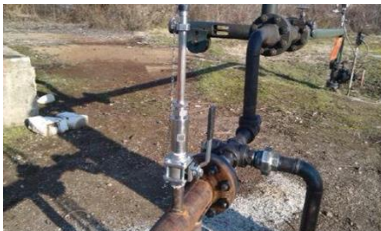
Slika 4-9. Metalni kupon na vrhu eksploatacijske bušotine (INA d.d., 2017 b)
