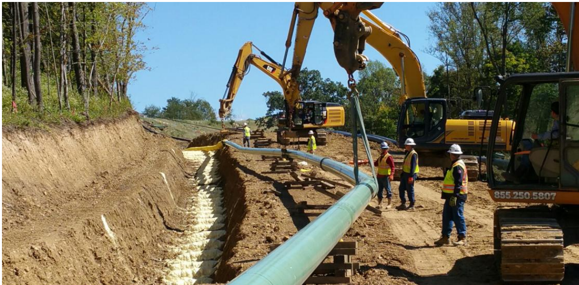
Slika 2-4. Izgradnja naftovoda (Capstone Energy Services, 2018)
