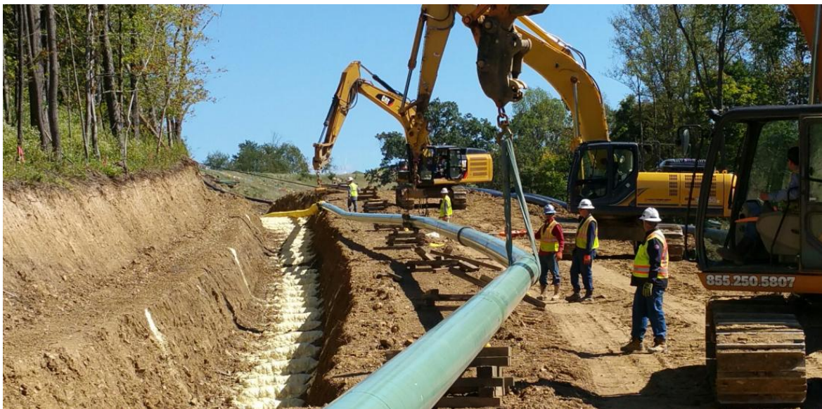
Slika 2-4. Izgradnja naftovoda (Capstone Energy Services, 2018)
