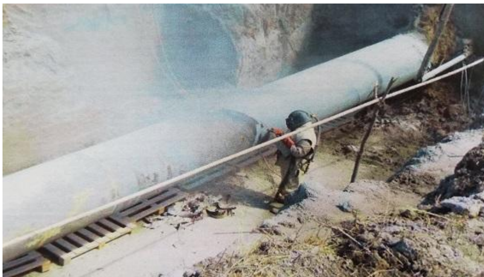
Slika 5-8. Postupak pjeskarenja cijevi (JANAF D.D., 2016)
