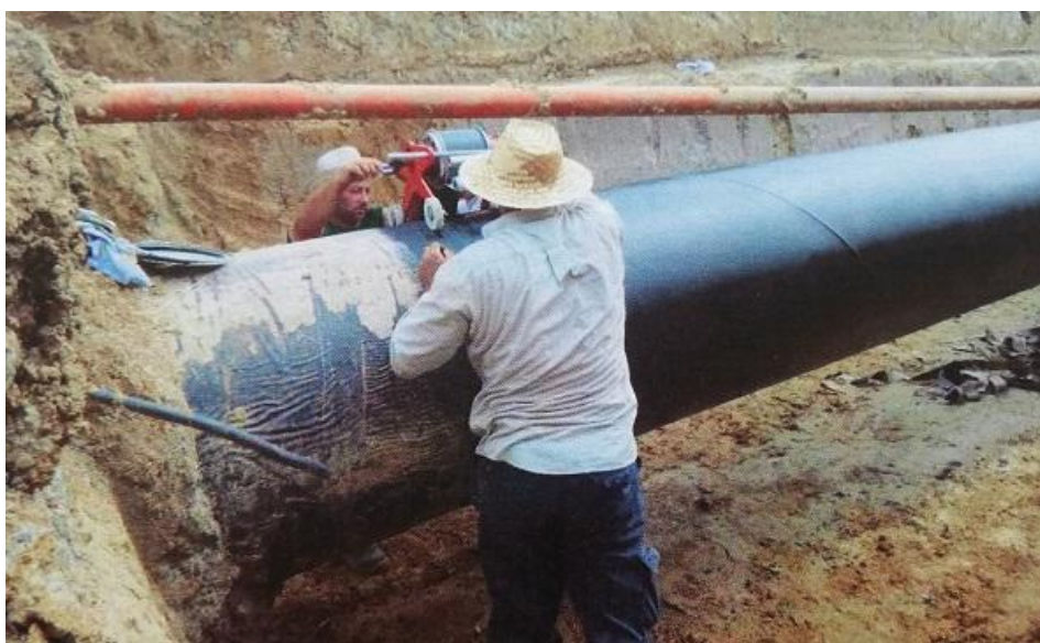
Slika 5-9. Postavljanje antikoroziivne trake (JANAF D.D., 2016)
