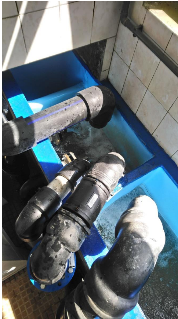
Slika 3-1 Pojedinačni cjevovodi s izvora u crpnoj stanici
