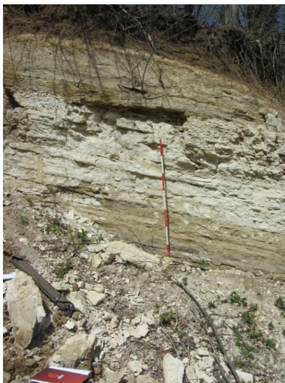
Slika 2.3. Pogled na profil lapora na klizištu Trstenik (fotografirano 12. travnja 2018)
