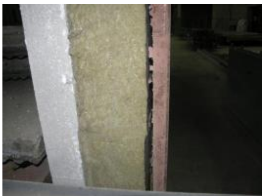
Slika 4-7: ventilirajući sloj (ECO-SANDWICH, 2015)
