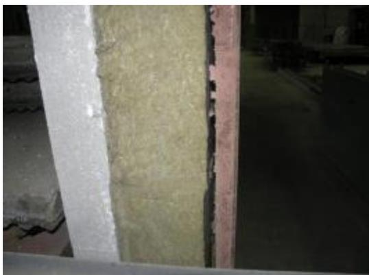
Slika 4-7: ventilirajući sloj (ECO-SANDWICH, 2015)
