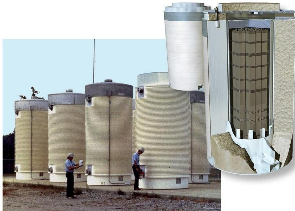
Slika 3-5 Spremnići za suho skladištenje iskorištenog nuklearnog goriva
