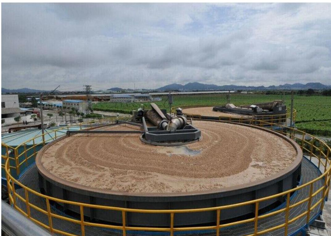
Slika 2-6 Flotacija (Seawater ro plant, 2018)
