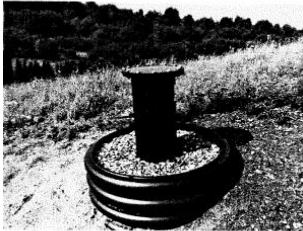
Slika 6. 4. Biofilter na odlagalištu otpada Tarno (H-PROJEKT 2018).
