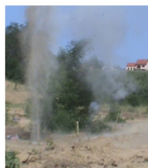
Slika 7.30 Trenutak aktiviranja eksplozivnog punjenja
