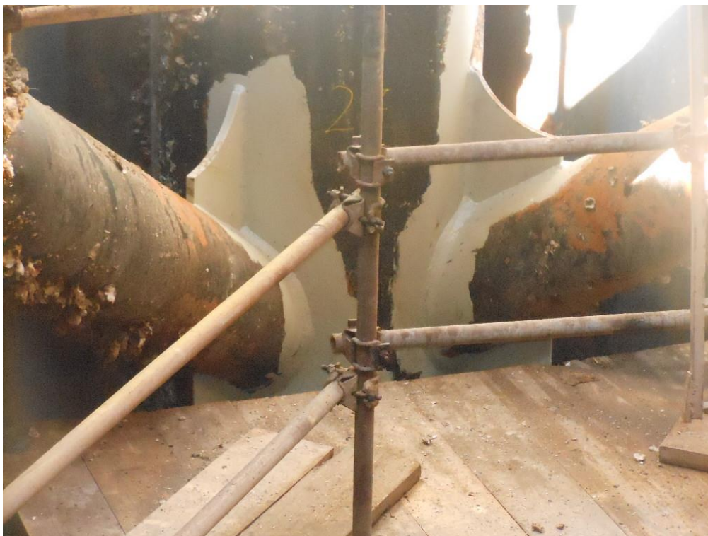
Slika 5-1. Noga označena vodootpornom žutom kredom (Crosco, 2014c)
