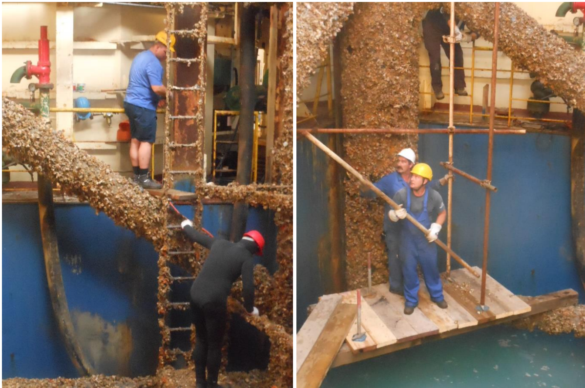
Slika 5-3. Vizualni pregled dijelova stope – CVI (Crosco, 2014c)
