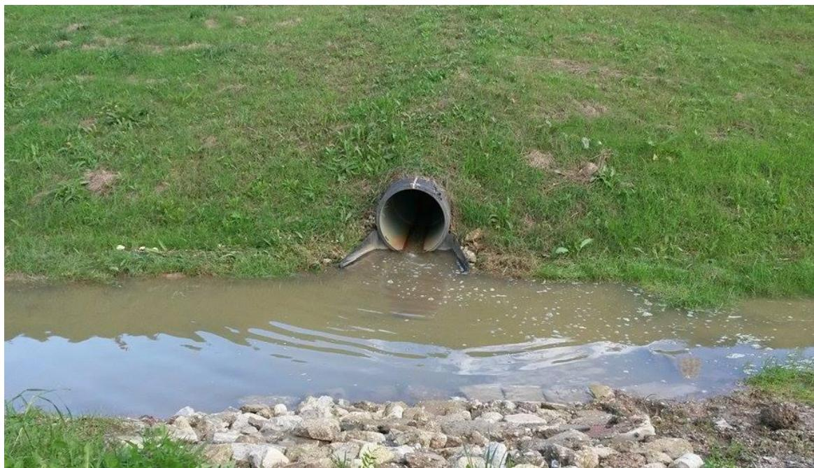
Slika 3-6. Obodni kanal i drenažna cijev
