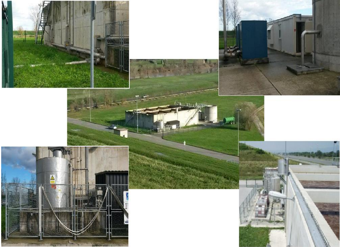
Slika 3-9. Pročišćivač otpadnih voda
