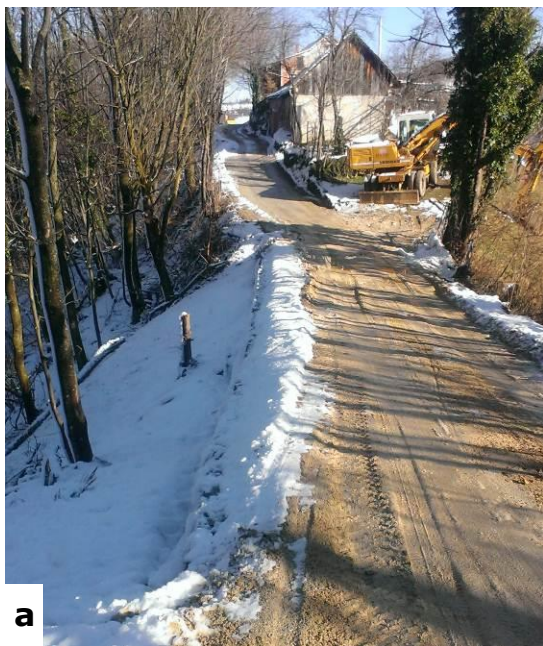
Slika 3.2 Klizište Cerina 1: (a) pogled na izvedeni gabionski zid visine 3 m koji je izgrađen u siječnju 2015. kao privremena mjera sanacije (fotografirano 31.1.2015.); (b) asfaltirana prometnica na lokaciji Cerina 1 (fotografirano 30.4.2015.).
