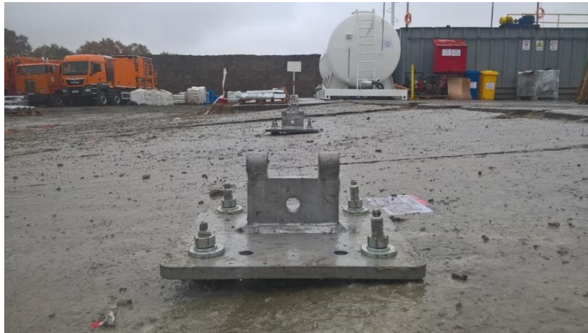
Slika 3-1. Bazna ploča šatora (Crosco, 2017b)
