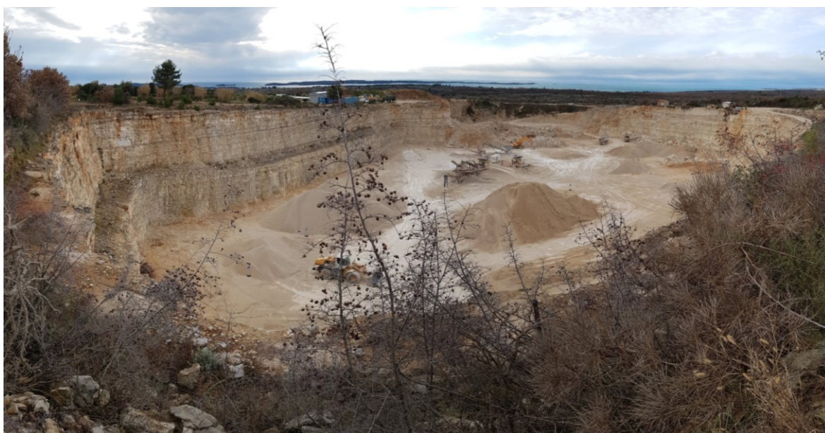
Slika 3-5. Otvorene etaže površinskog kopa "Tambura" (preuzeto iz Farkaš i dr., 2019)
