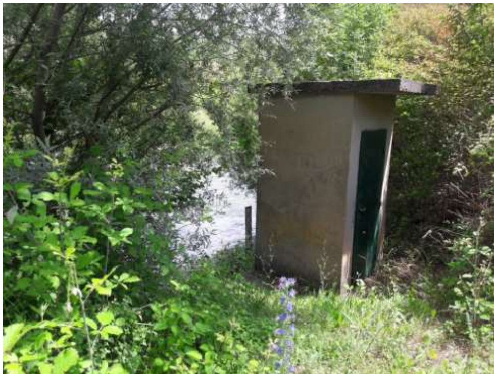
Slika 4.4. Hidrološka stanica Ruda 1
