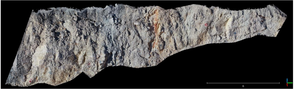
Slika 6.1 Oblak točaka snimljen na gornjem dijelu 3. etaže na stacionaži 0+150 – 0+170 (model 3e_g_150-170)
