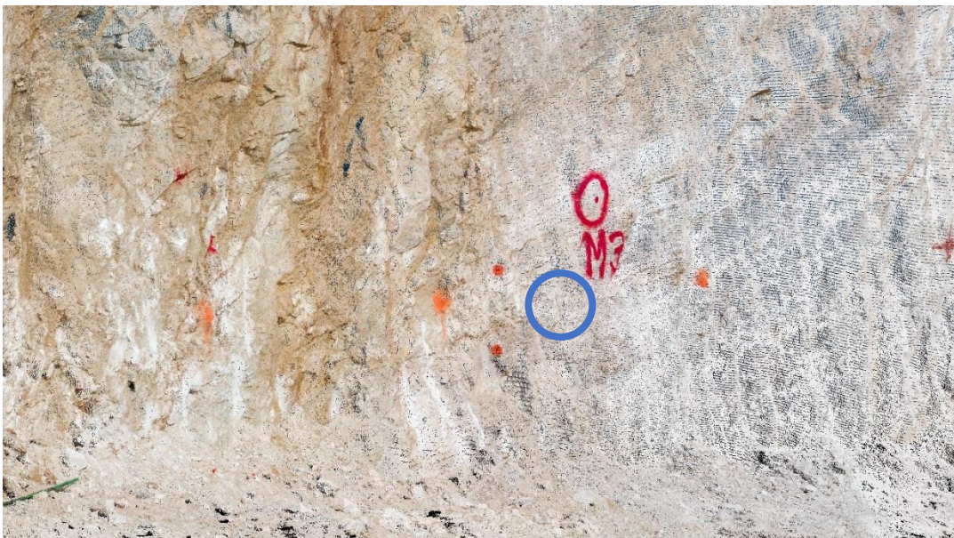
Slika 7.3 Trodimenzionalni oblak točaka s označenim mjestom mjerenja diskontinuiteta sa slike 7.2 (plavi krug). Orijentacija izmjerenog diskontinuiteta je 337/78.
