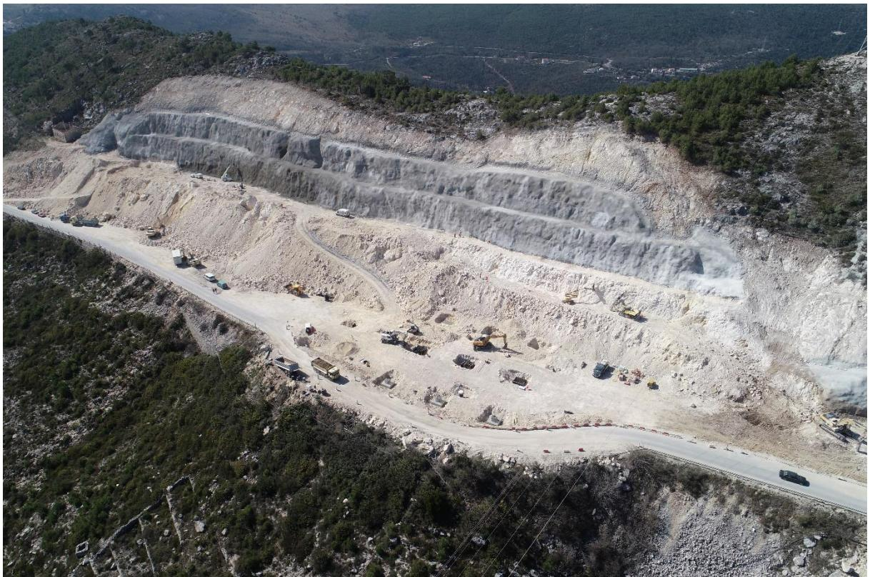
Slika 5.2 Fotografija snimljena dronom na gradilištu stalnog graničnog prijelaza Gornji Brgat s vidljive tri otkopane etaže, dvije torkretirane betonom i jedne zaštićene mrežom (gornja etaža)
