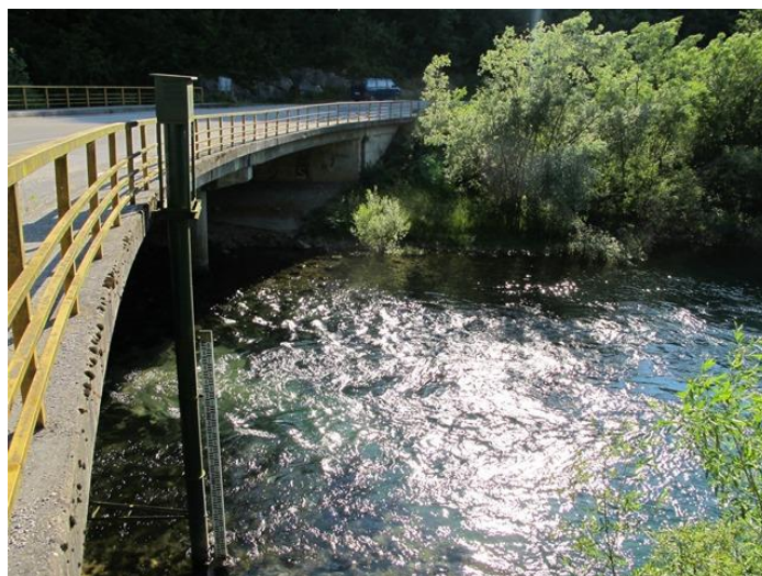
Slika 4.1. Hidrološka postaja Juzbašići ( http://hidro.dhz.hr/ )
