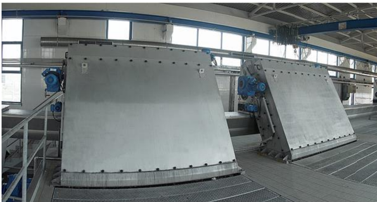
Slika 6-2. Zgrada s finim rešetkama (ZOV 2009)
