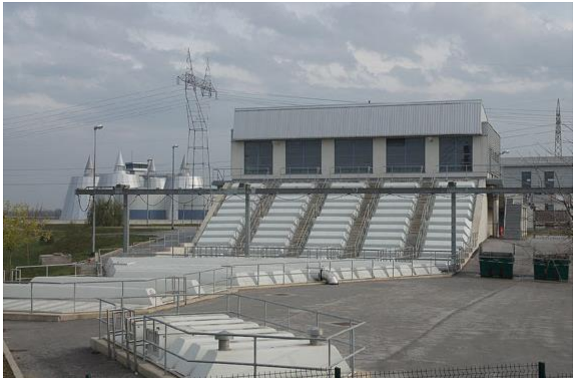
Slika 6-1. Ulazna crpna stanica s grubom rešetkom (ZOV 2009)
