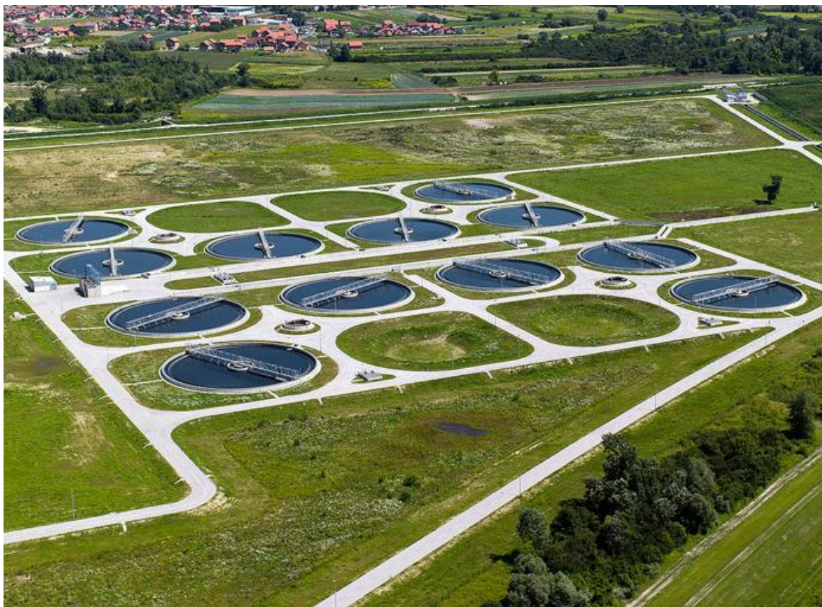
Slika 6-3. Naknadni taložnici (ZOV 2009)
