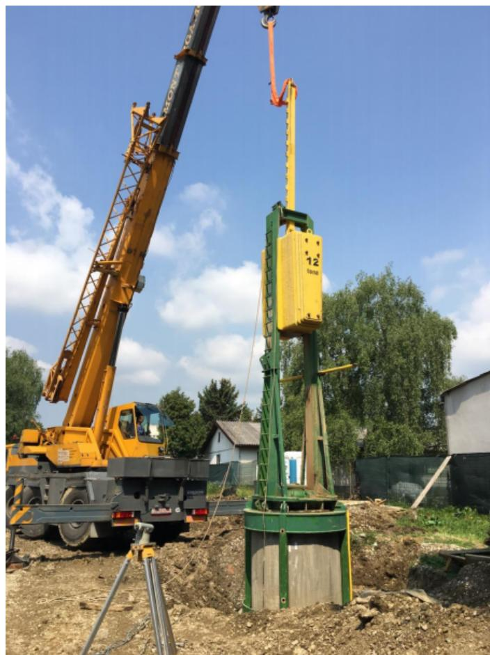
Slika 6-1 Ispitivanje probnog pilota promjera 150 cm (Matković, 2017)
