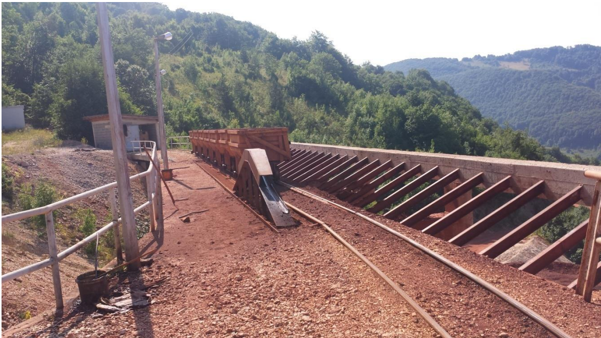
Slika 3-3. Istovarna rampa
