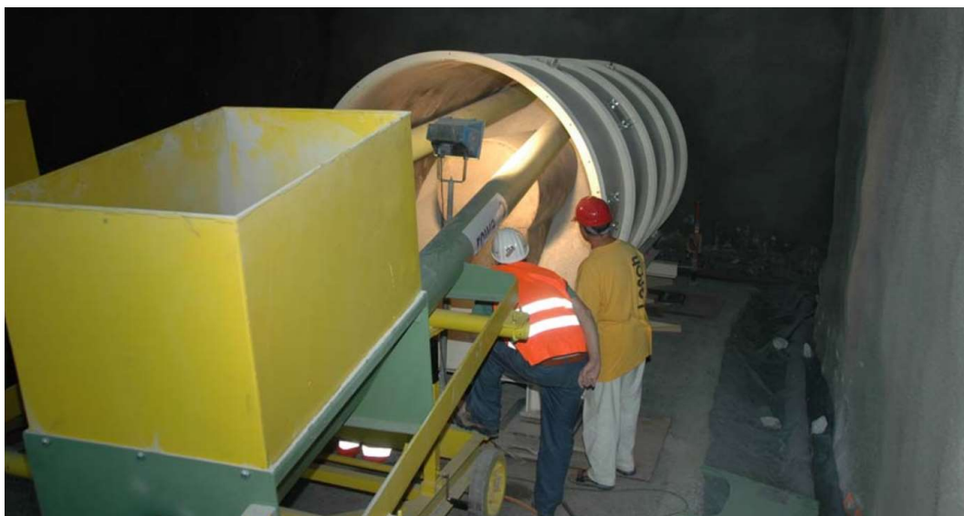
Slika 3-22 Testiranje tehnologije zapunjavanja prostora oko spremnika bentonitnim peletima (Fries i dr., 2008)
