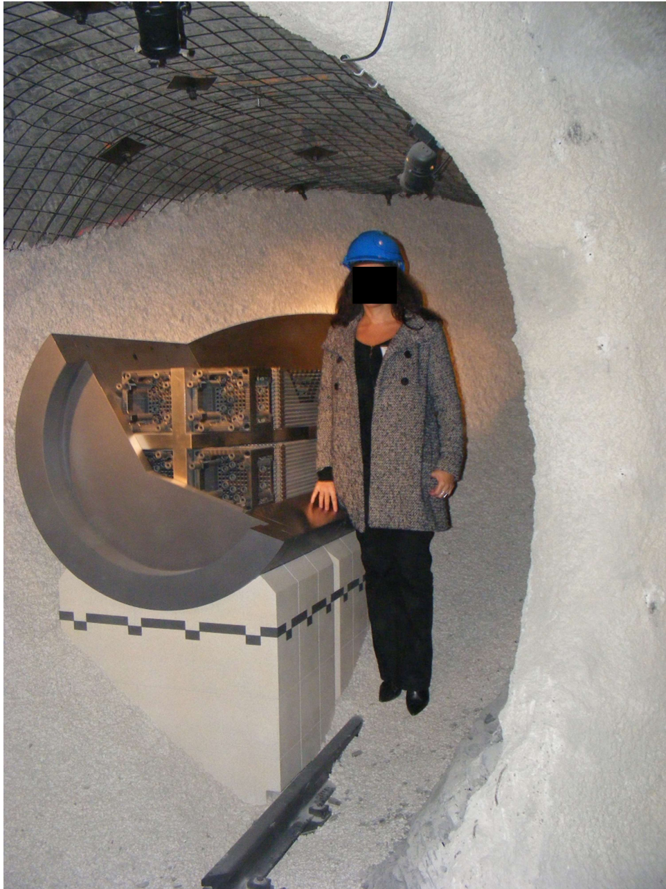
Slika 3-21 Spremnik na posteljici od prešanog bentonita u peletima djelomično zapunjenom odlagališnom hodniku, vidi se podgrada (čeličnom mrežom i sidrima – opcija u slučaju potrebe i transportne tračnice) (izvor: doc.dr.sc. Želimir Veinović, privatna zbirka).
